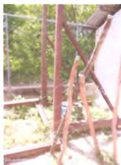
CERCO O MURO PERIMETRAL, REPARACION
