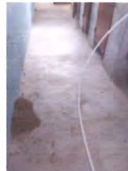
SUSTITUCION DE PISO ALISADO CON FISURAS POR PISO
