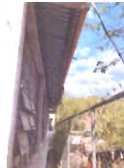
CANALES Y BAJADAS DE AGUA PLUVIAL, SUSTITUCION CANALES EN MAL ESTADO
